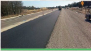
Yol Yapımı Malzemeleri ve Nakliyesi
