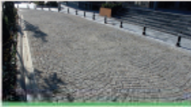
Site Yolları ve Kaldırım Yapım İşleri
