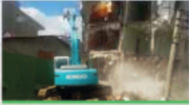
Bina Yıkım İşleri
