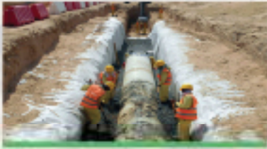
Kanalizasyon Altyapı İşleri
