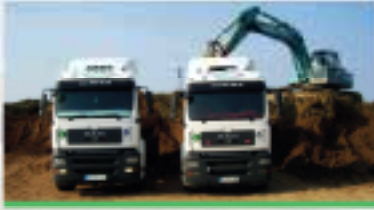
Şehir İçi ve Saha Hafriyatları
