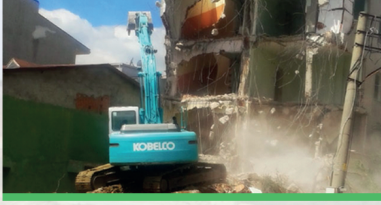
Bina Yıkım İşleri
