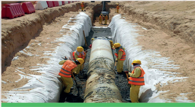
Kanalizasyon Altyapı İşleri
