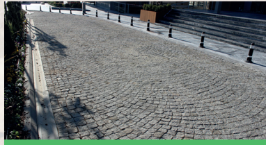
Site Yolları ve Kaldırım Yapım İşleri
