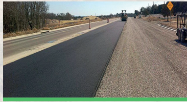
Yol Yapımı Malzemeleri ve Nakliyesi
