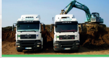
Şehir İçi ve Saha Hafriyatları
